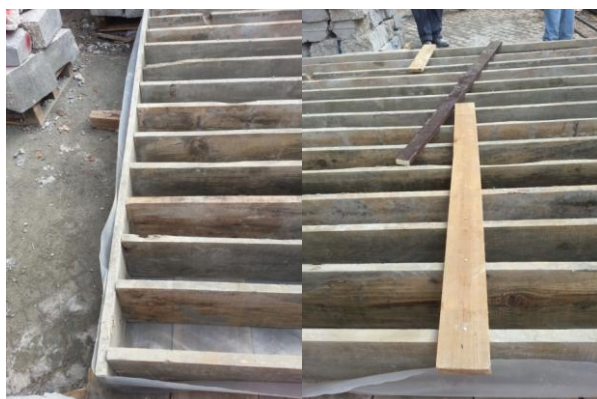
Figura 3.10 - Montagem da cofragem para recepção do BO.
