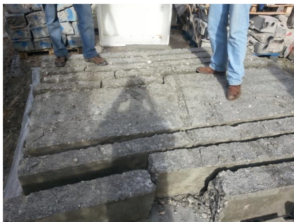
Figura 3.12 - Fracturação da laje de BO em blocos.
