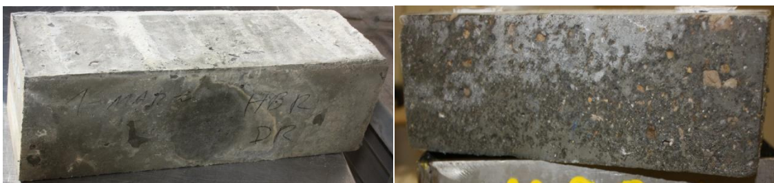
Figura 4.24 - Betão HBR - No início (esquerda) e ao fim de 300 ciclos de gelo-degelo (direita).
