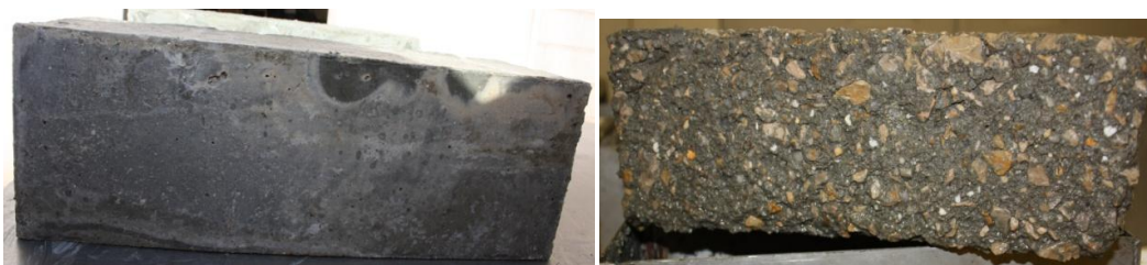
Figura 4.20 - Betão BR - No início (esquerda) e ao fim de 300 ciclos de gelo-degelo (direita).
