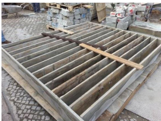
Figura 3.1 - Sistema de cofragem para a betonagem do betão de origem
