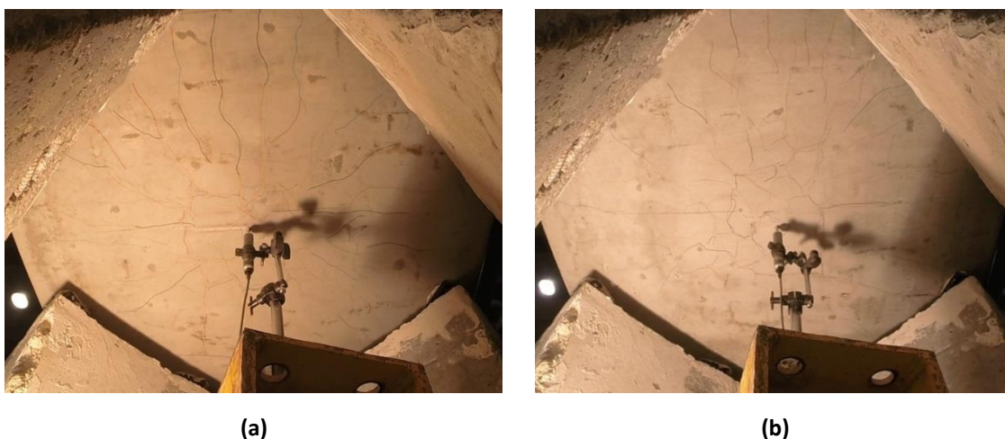
Figura 4.9 - Face inferior do modelo antes da rotura: (a) BR-1; (b) B100-2
