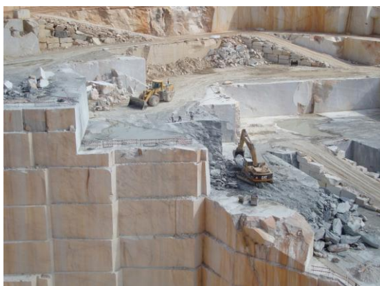
Figura 2.6 - Limpeza da frente de desmonte
