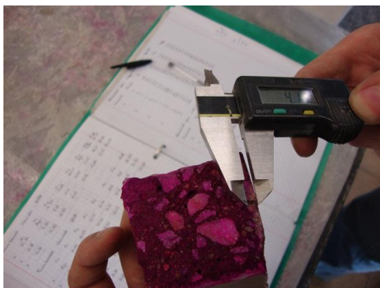
Figura 3.22 - Medição da profundidade da frente de carbonatação
