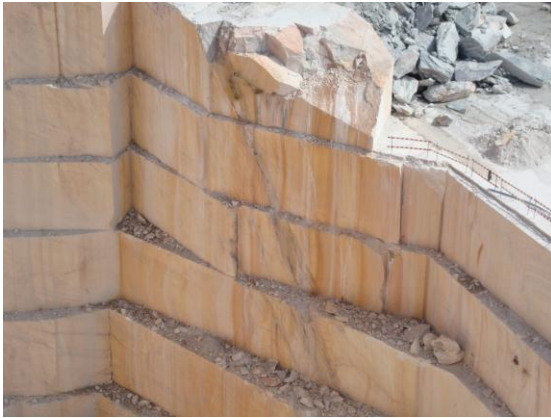
Figura 2.3 - Descontinuidade em bloco de mármore
