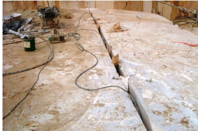
Figura 2.8 - Afastamento com o colchão hidráulico
