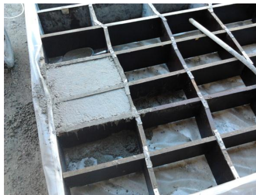
Figura 3.2 - Pormenor do preenchimento da cofragem
