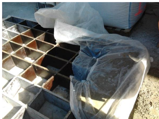
Figura 3.1 - Cofragem em contraplacado marítimo
