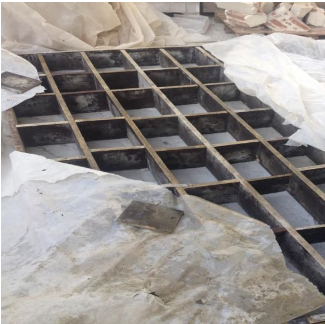
Figura 3.7 - Cofragem em contraplacado marítimo
