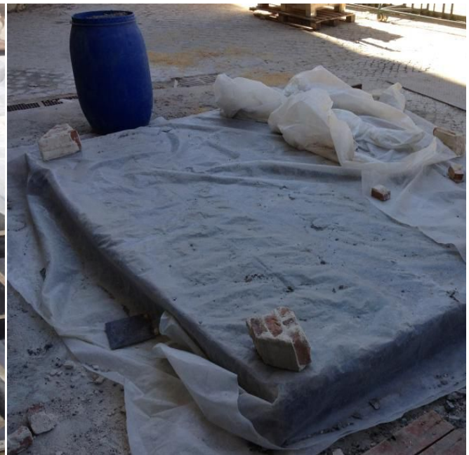
Figura 3.8 - Cofragem betonada
