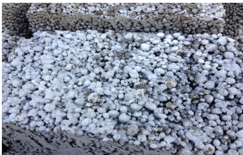
Figura 3. 12 - Bloco do betão de origem BOM
