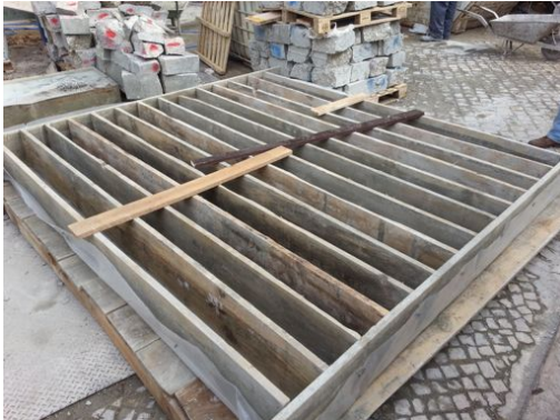
Figura 3.1 – Cofragem para produção do BO
