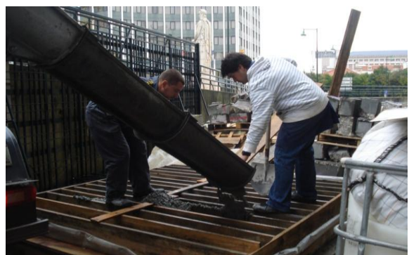
Figura 6 - Betonagem de um dos betões de laboratório
