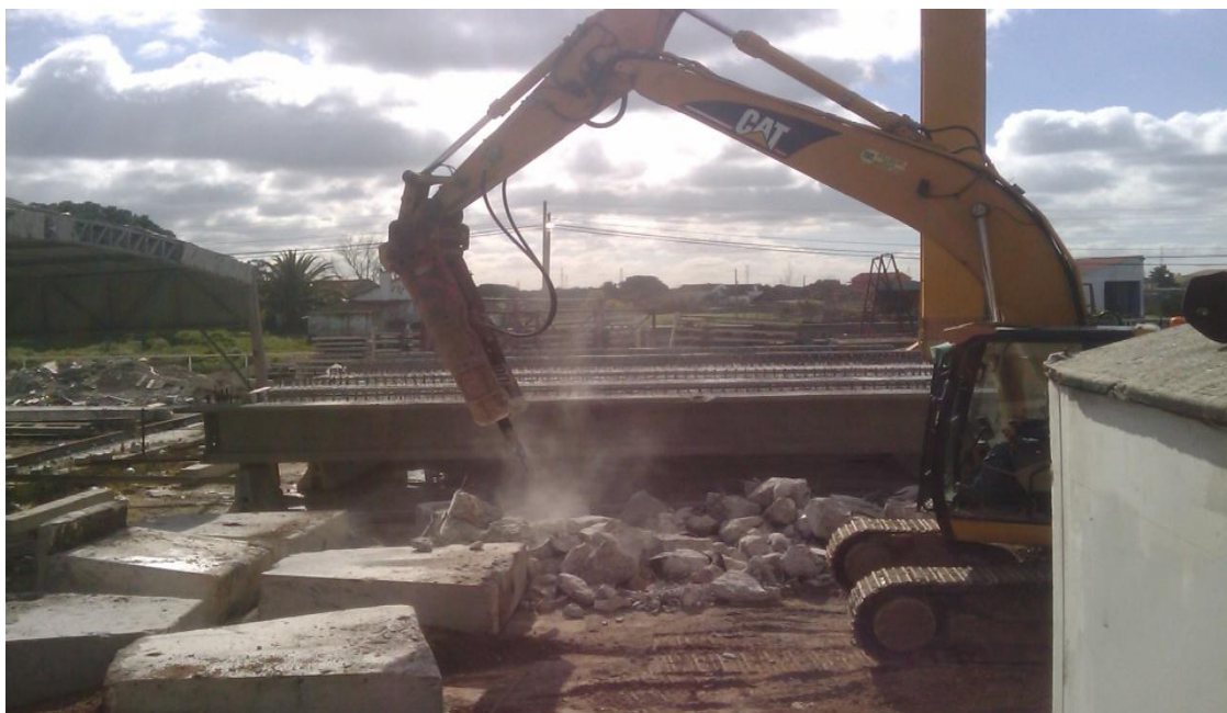
Figura 7 - Pulverização de um tipo de betão proveniente da pré-fabricação
